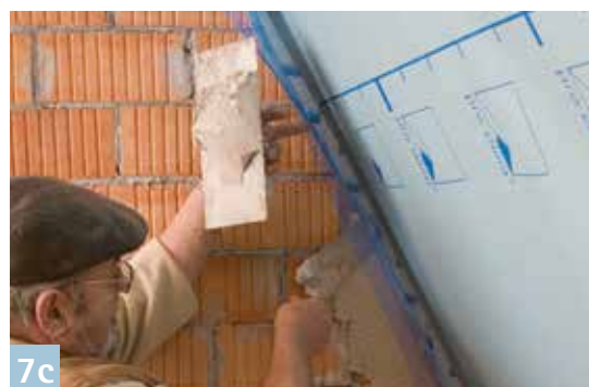
CONTEGA PV Pleisteraansluitband voor gedefinieerde, duurzaam veilige aansluitingen op te pleisteren ondergronden
