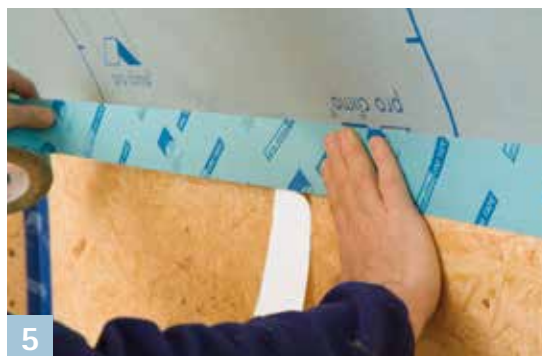
5 Aansluiting op gladde, niet-minerale ondergronden ...
