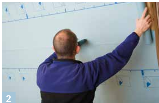
2 Banen overlappen bij aanbrenge dwars
