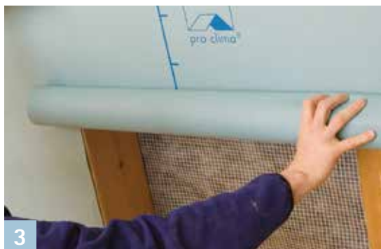
3 Banen overlappen bij aanbrenge overlangs
