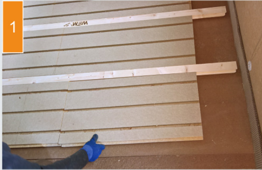
(1) De houtvezel-vloerplaten en profielen worden gelegd.
