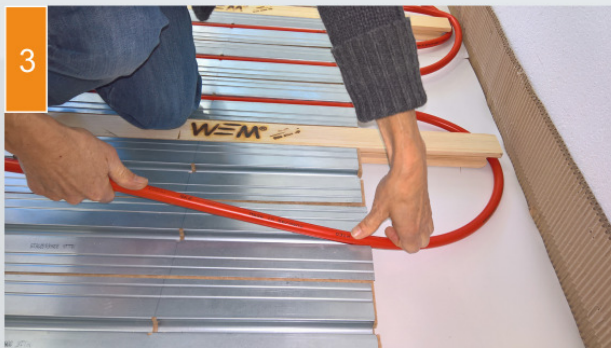
(3) De buis wordt in de warmtegeleidende metaalplaten gelegd en op de verdeler of Multibox aangesloten.
