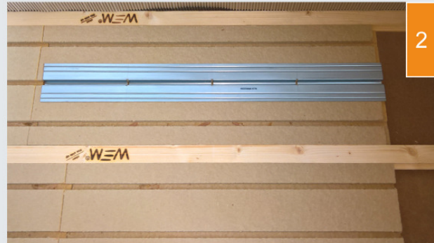
(2) Warmtegeleidende metaalplaten worden in de vloerplaten gelegd.
