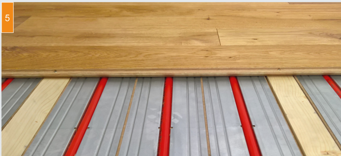
(5) Er wordt een geschikte houten vloer gelegd.
