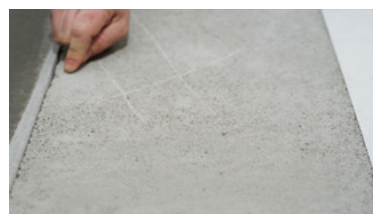
CEMENTDEKVLOEREN hardheid en reiniging controleren
