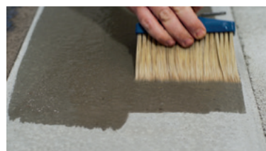
BETON absorptie controleren
