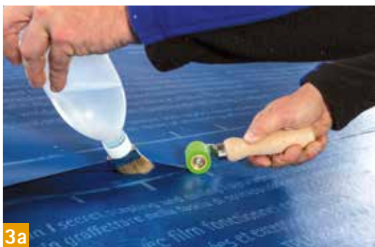
WELDANO TURGA Zwellasmiddel voor het SOLITEX WELDANO-onderdakstelsel
