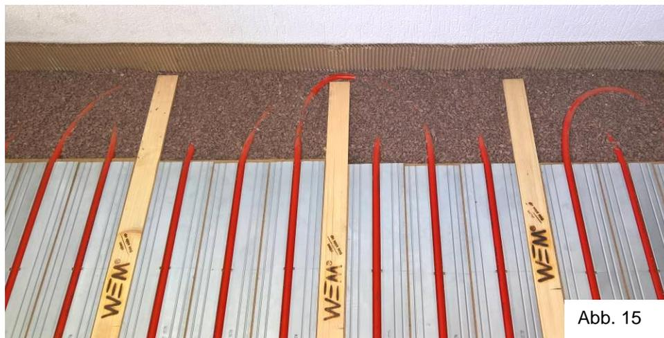
**Bodenbelag verlegen** Die Dielen werden an den Profilen verschraubt (Abb. 16). Die Befestigungsschrauben der ersten und letzten Diele müssen mindestens 50 mm von der Wand entfernt sein, damit das Rohr nicht durch Hineinschrauben beschädigt werden kann.
