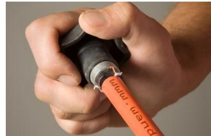
Kontrollieren Sie anschließend, ob die innere Rohrwand eine gleichmäßige umlaufende Fase hat.
