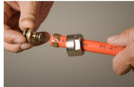
Erst Überwurfmutter, dann Klemmring auf das Rohr aufschieben.
