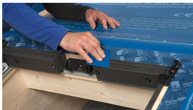
26. Gebruik TESCON VANA om alles te fixeren.
