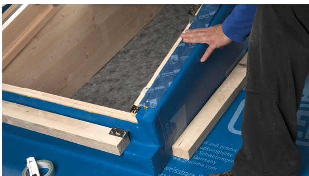
23. Gebruik TESCON VANA om alles te fixeren.
