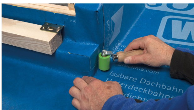
29. Las het stuk SOLITEX WELDANO 3000 vast.
