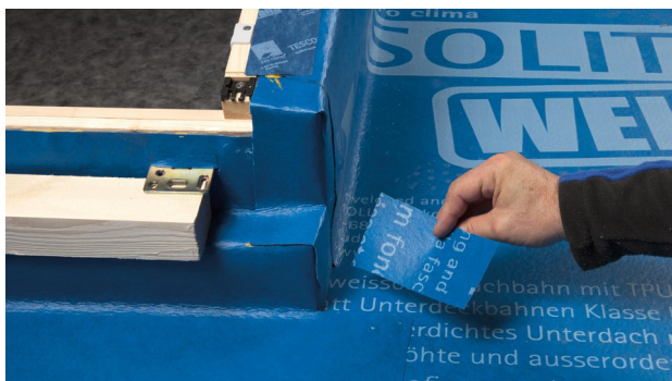
27. Snijd een klein stuk SOLITEX WELDANO 3000 uit om de lasen bij de onderste hoek te bedekken.
