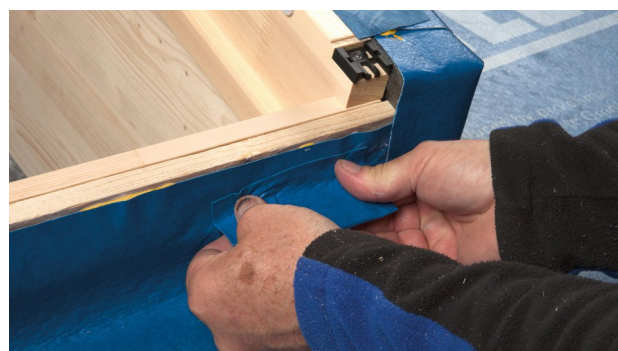
32. Las de stukken vast om de montagehoeken.
