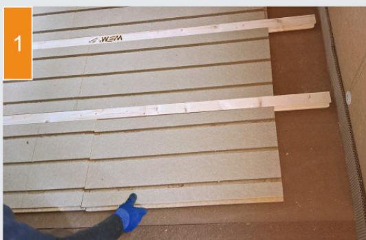
(1) De houtvezel-vloerplaten en profielen worden gelegd.
