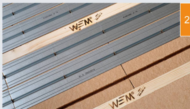
(2) Warmtegeleidende metaalplaten worden in de vloerplaten gelegd.
