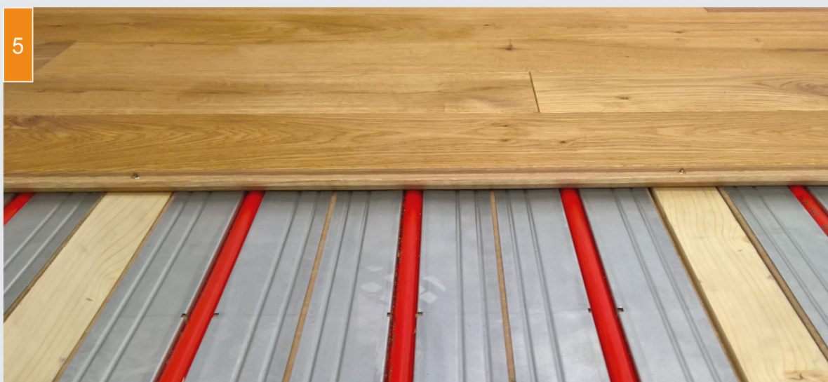
(5) Er wordt een vloer gelegd (in dit geval houten vloerdelen).
