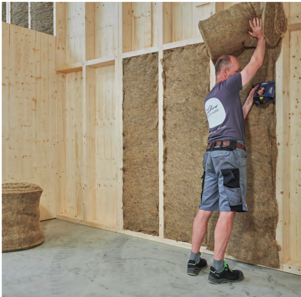
Bij biobased bouwen is luchtdichting belangrijker dan dampremming.
