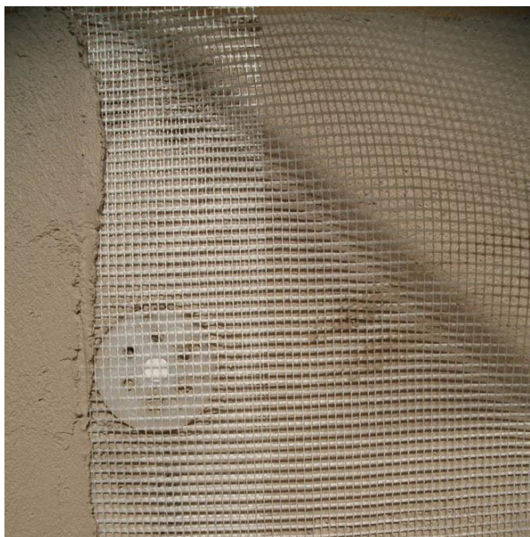
Fig 2. Glasweefsel LIMETICS® PC150 en mechanische bevestiging EJOTHERM® STRU
