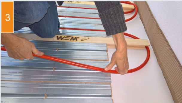
(3) De buis wordt in de warmtegeleidende metaalplaten gelegd en op de verdeler aangesloten.
