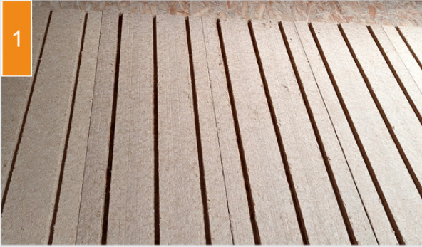
(1) De houtvezel-vloerplaten worden gelegd.
