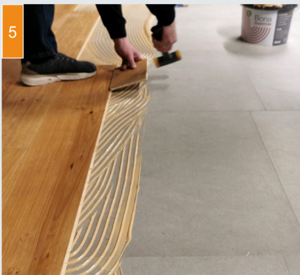
(5) Het parket wordt op de Ceralan-ondergrond gelegd.
