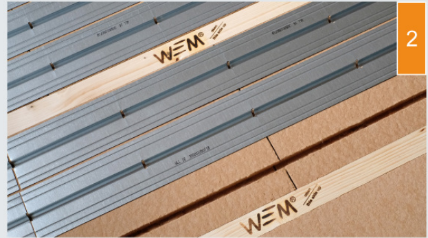
(2) Warmtegeleidende metaalplaten worden in de vloerpanelen gelegd.
