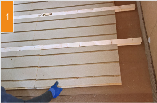
(1) De houtvezel-vloerplaten en profielen worden gelegd.
