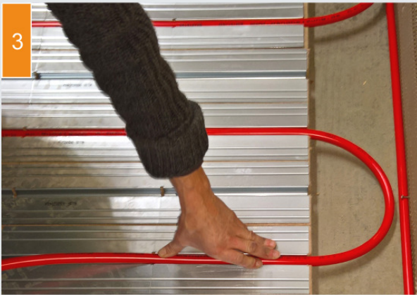
(3) De buis wordt gelegd en de randdelen worden met isolatiekorrels gevuld.
