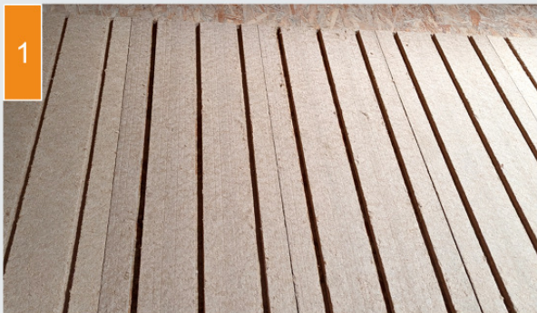
(1) De houtvezel-vloerplaten worden gelegd.
