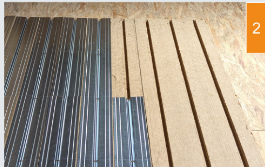
(2) Warmtegeleidende metaalplaten worden in de vloerplaten gelegd.
