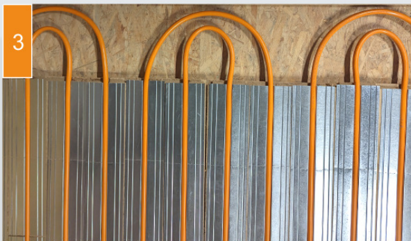
(3) De buis wordt gelegd en de randdelen worden met isolatiekorrels gevuld.
