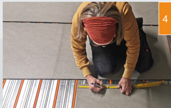
(4) De Ceralanplaten worden gelegd.
