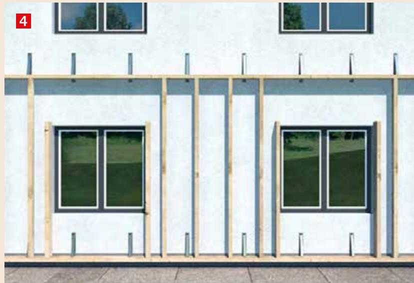
**1** Als nächstes werden die Positionen der Stiele im EG angezeichnet, auf die Schwelle gestellt und befestigt. Die Stiele an den Außenseiten und Öffnungen haben die volle Gefachtiefe. Alle übrigen Stiele werden auf Abstand zur Wand montiert.
