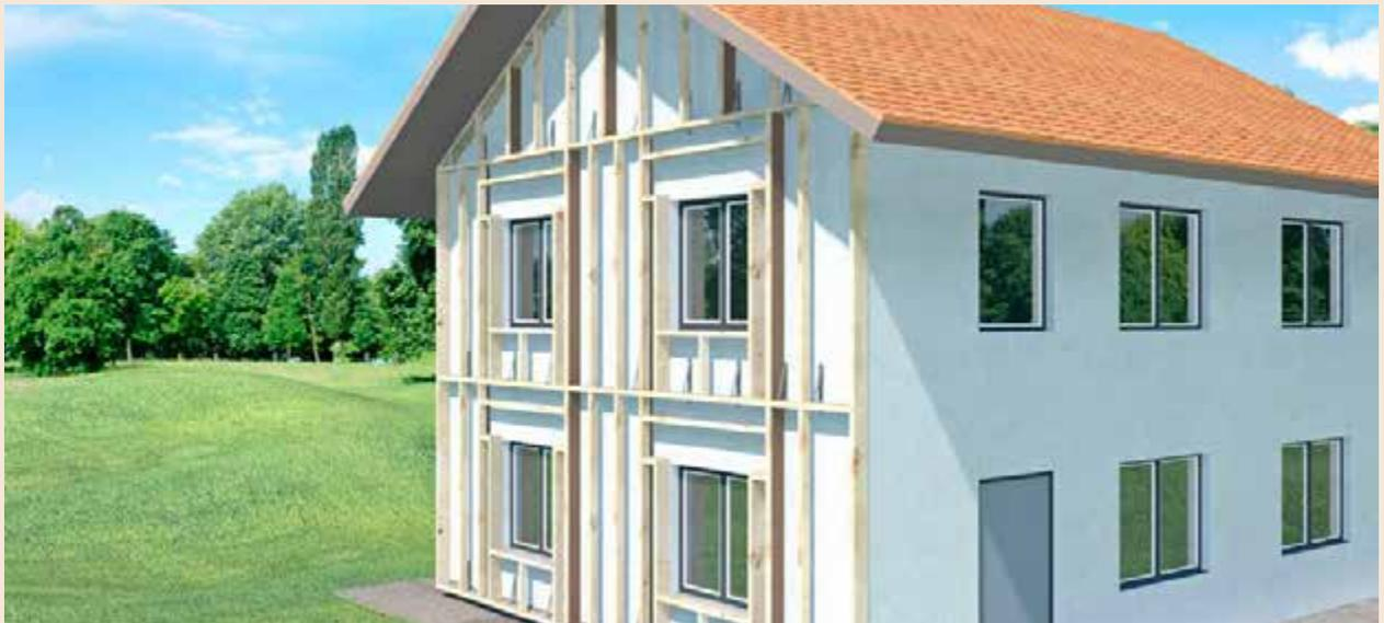
**1** Zur Vorbereitung der Thermofibre Einblasdämmung werden mit der Durio® Schottplatte vorab einzelne Gefache voneinander abgetrennt. Dies ist erforderlich, da die Stiele auf Abstand zur Bestandswand montiert sind und gewährleistet eine ordnungsgemäße Verdichtung in jedem Gefach.
