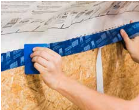
... aansluitingen op houten platen,
