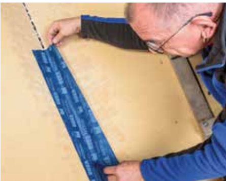
Tape kan direct in de primer worden verkleefd.
