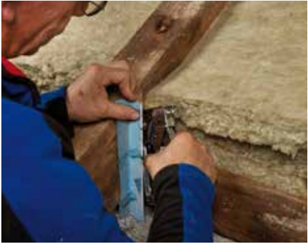
... en bevestig de hoeklijst aan de spoor.
