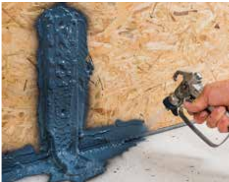
Luchtdicht bespuiten van bevestigingshoeken,
