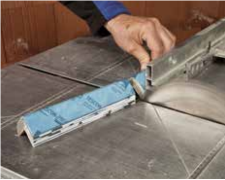
Snijd TESCON FIX op de gewenste lengte af
