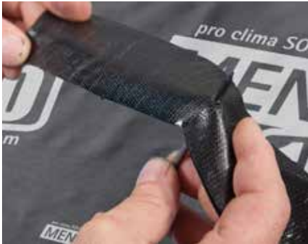
TESCON NAIDECK wordt door de nagel meegetrokken en dicht betrouwbaar af.
