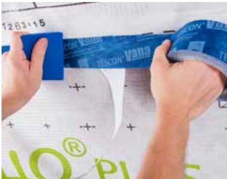
Verkleving van folieoverlappingsen binnen,
