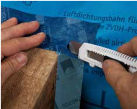
Sluit de folie met TESCON VANA luchtdicht aan op de spoor.
