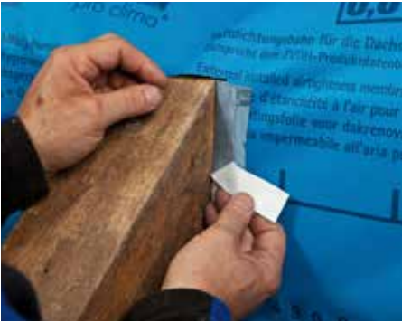
Verwijder de schutlaag en verkleef de folie luchtdicht op de spoor.
