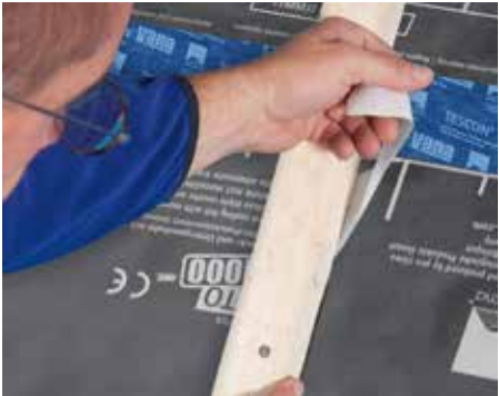
Verwijder stap voor stap de schutlaag.
