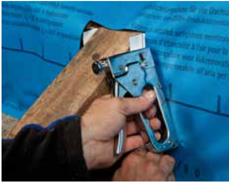
Niet de folie vast aan de hoeklijst.
