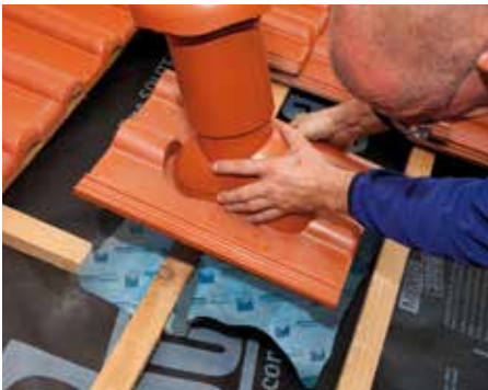
ROFLEX exto voor eenvoudige verkleving onder dakdoorvoerpannen
