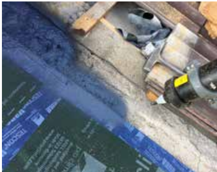
... op ruw beton,
