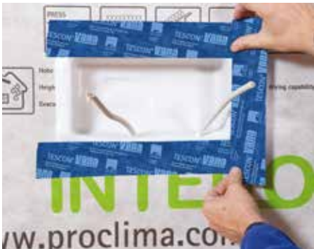
INSTAABOX creëert ruimte voor schakelaars en contactdozen.
