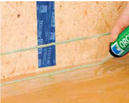
... en aansluitingen van houten platen op vloeren
