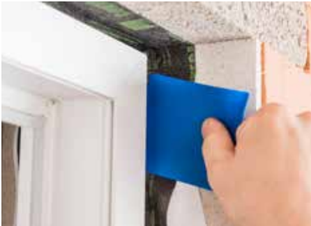
Wrijf de tape stevig aan met PRESSFIX.
