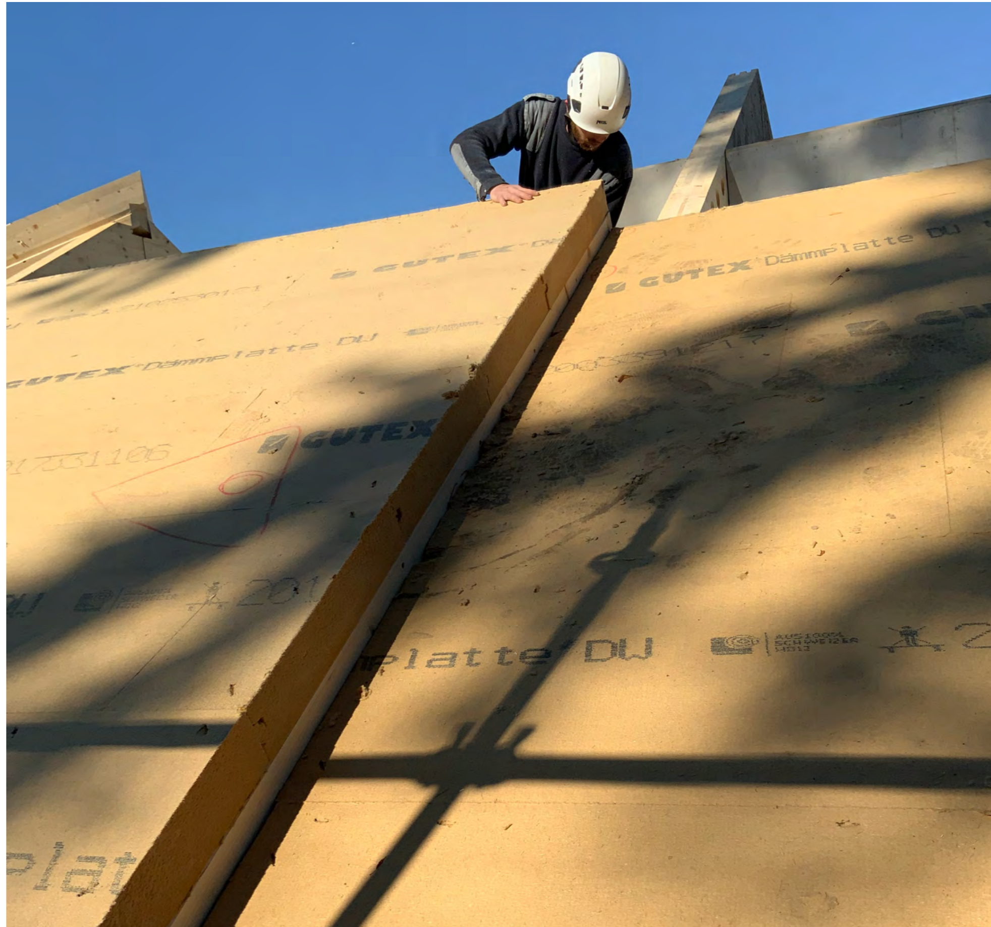
■ St-Légier ■ Luca Delachaux und Gerald Volet ■ Gutex Holzfaserdämmplatte DW ■ Atelier Volet Charpentier / Bâtitseur SA Beratung Association Monuments Historiques, Nicolas Meyer ■ Architectes Associés Glatz & Delachaux
