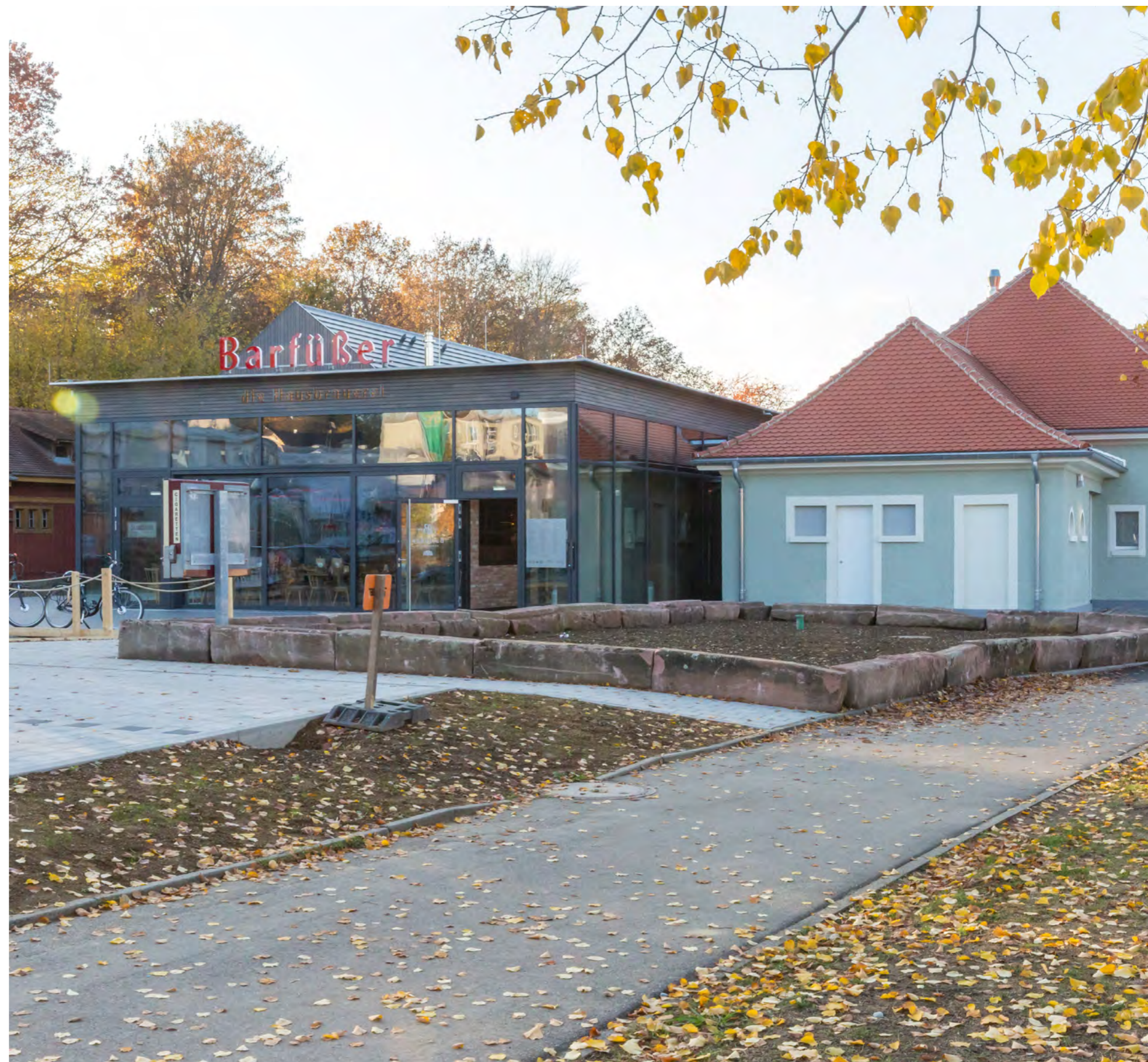
■ Pfullendorf ■ Gutex Thermoroom, Multiplex-top, WDVS ■ Ing.-Büro Jens Künstle ■ Erwin Künstle ■ Martin Granacher ■ Holzbau Künstle
