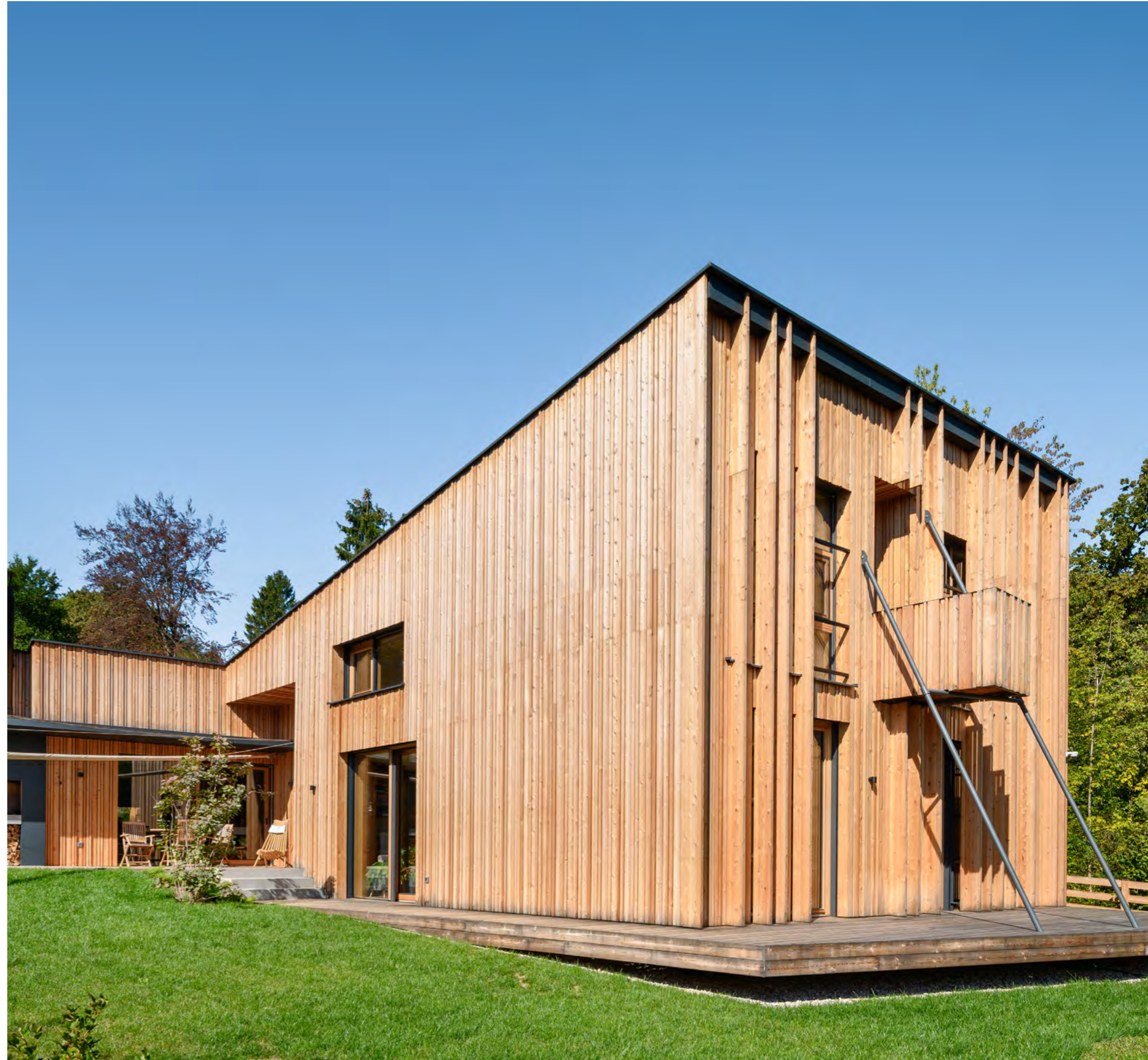
■ Passivhaus bei Ljubljana ■ Gutex Thermowall, Thermoinstal, Multiplex-top ■ Büro Biro Gasperic, Ljubljana ■ Privat ■ Miran Kambič ■ Bauta, Cerklje na Gorenjskem
