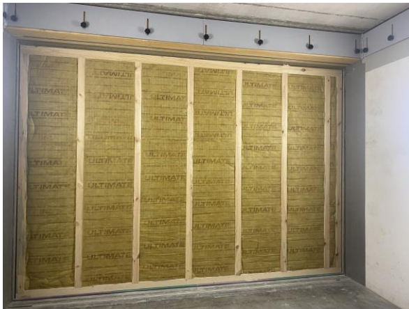
Tragkonstruktion mit Dämmung (Ansicht vom Empfangsraum)
